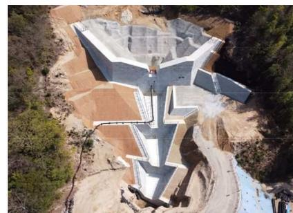
砂防堰堤の整備(呉市天応地区)
