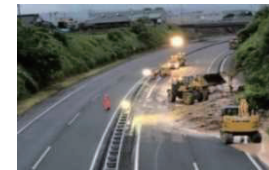
被害のない2車線を活用し、交通機能を確保
