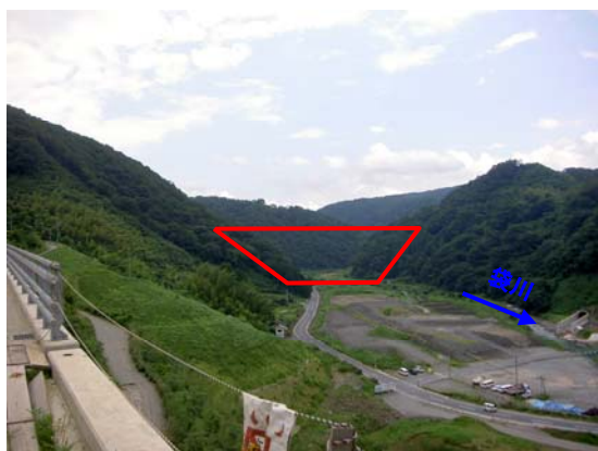
ダムサイト状況(下流より)
