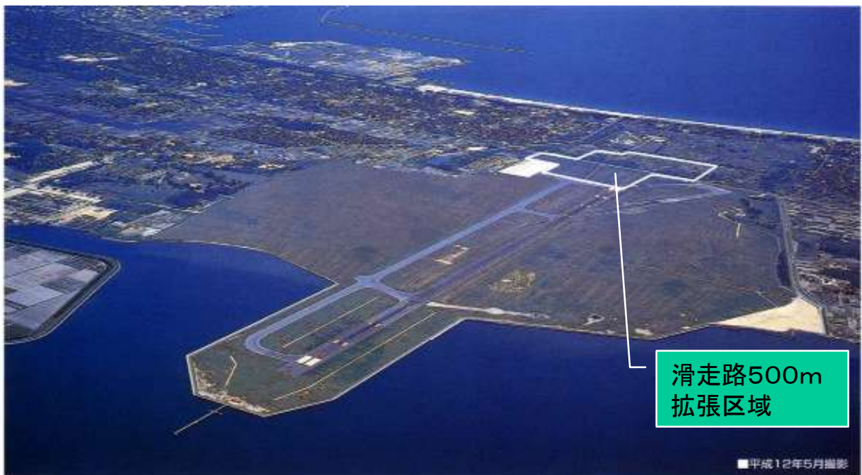
美保飛行場滑走路延長事業施工位置
