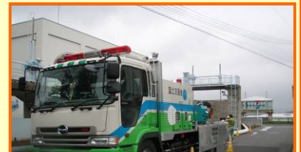
①(1)排水ポンプ車による排水 (島根県松江市)
