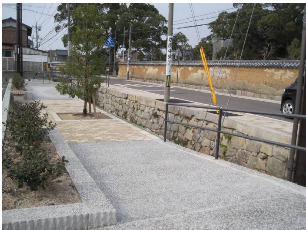
用水路の改善とポケットパークの整備
