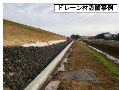
浸透対策実施事例
