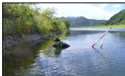
護岸基礎（水中部）の点検
