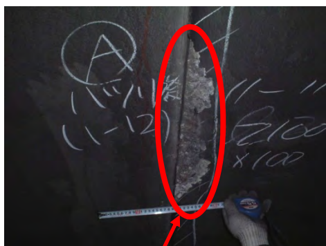
壁面の剥落
