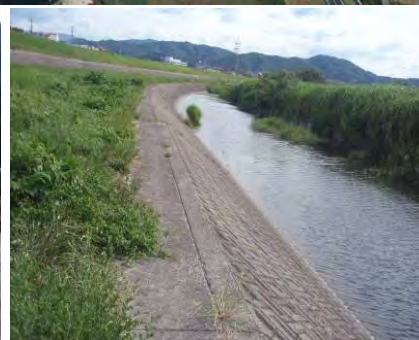
対策事例 (侵食対策のための低水護岸)
