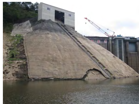
ダムサイト左岸（係船設備）
