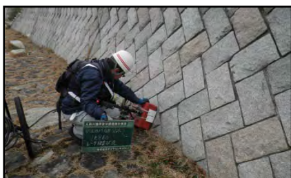
護岸背後の空洞化調査
