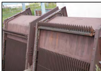
排水機場の除塵機補修
