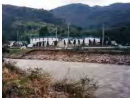
平成10年10月洪水 河岸侵食箇所（三朝町）
