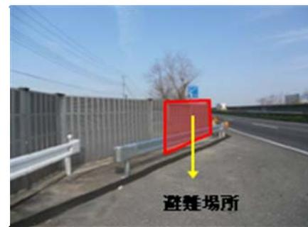
写真4 緊急避難階段の整備例
