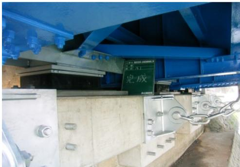
写真11 落橋防止装置の例
