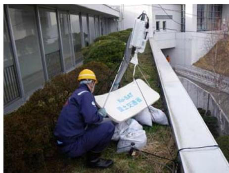
写真25 Ku-SAT II（衛星小型画像伝送装置）
