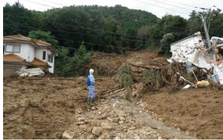
家屋の被災状況
