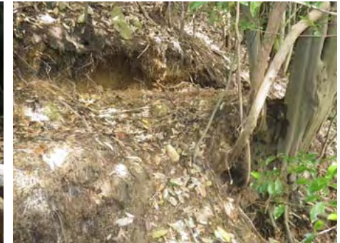
溪岸の不安定土塊の状況
