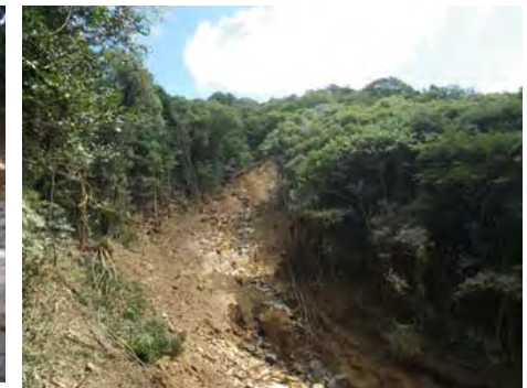
源頭部の崩壊状況
