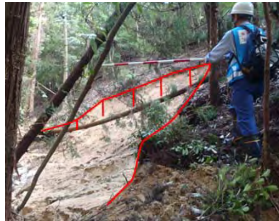
溪岸の崩壊状況(2)
