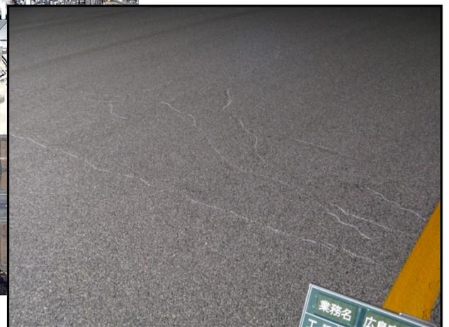
舗装表面の経年劣化によるひび割れの発生
