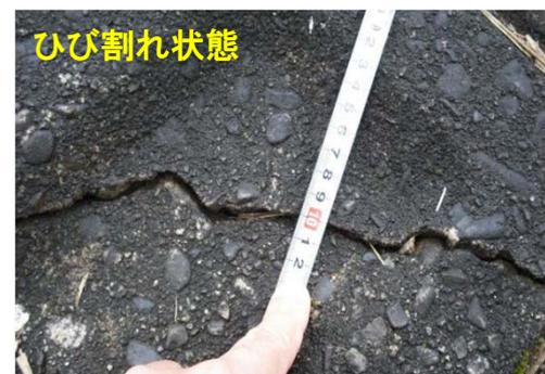
【老朽化した護岸の補修】 老朽化でひび割れが発生した護岸を補修し、施設の延命化を図ります。
