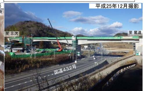
写真② 芦田川橋の橋梁上部工事の施工状況 (コンクリート製の橋を造っています)
