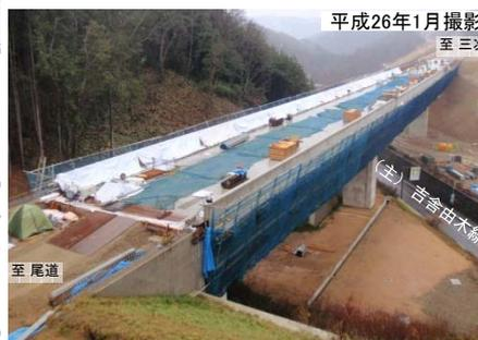
写真① 宇賀埵橋の橋梁上部工事の施工状況 (鋼製の走行面をコンクリートで造っています)
