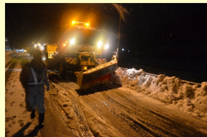
グレーダによる除雪作業状況 (徳島県三好市)
