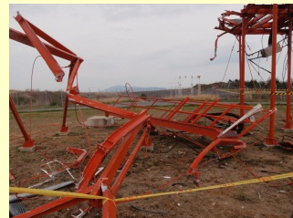
損傷したローカライザー
