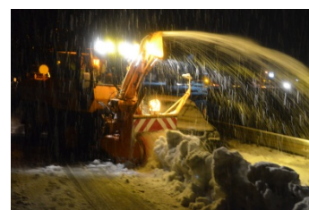
除雪作業状況（徳島県三好市）
