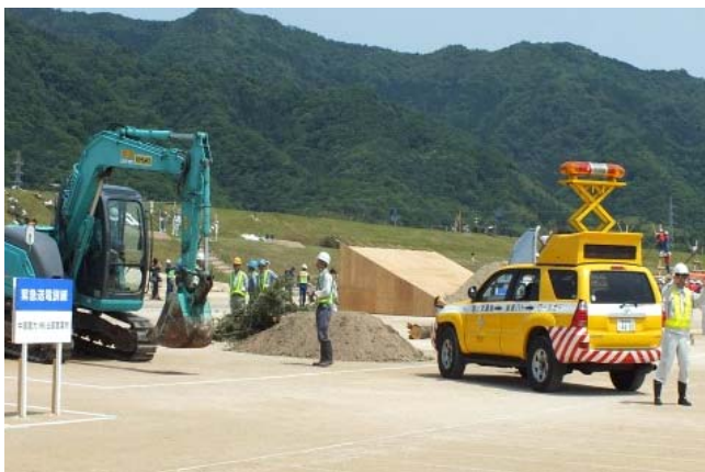
道路啓開訓練
