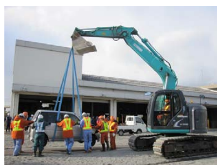
バックホウによる吊り上げ状況
