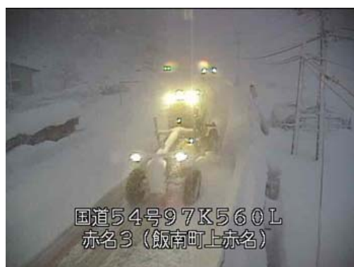
除雪作業状況
