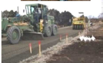
丁張りによる施工
