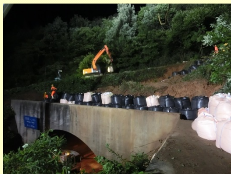
土砂流出復旧作業状況（福山市）
