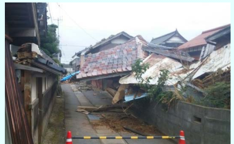
家屋の被災状況（東伯郡北栄町）
