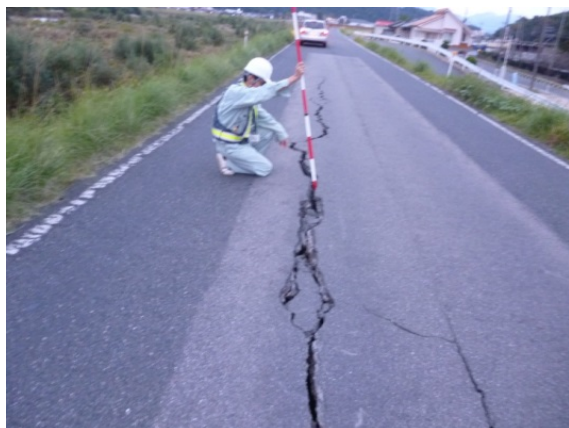
堤防施設の緊急点検（倉吉市）
