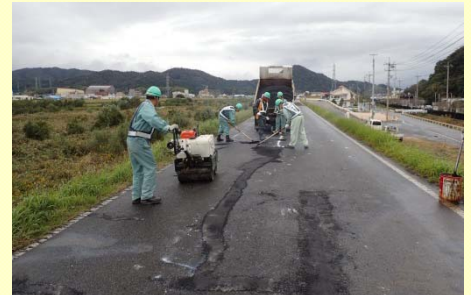
堤防応急復旧作業状況（倉吉市）
