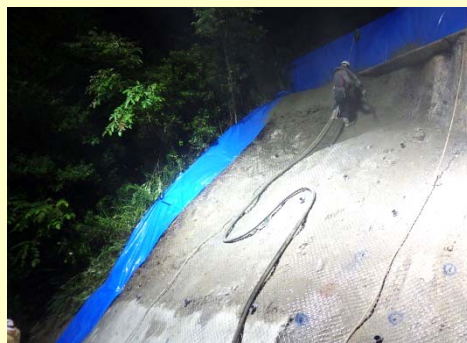
法面崩落復旧作業状況（東広島市）
