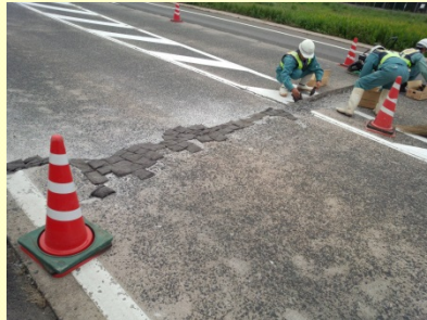
国道9号 応急復旧作業状況（北栄町）
