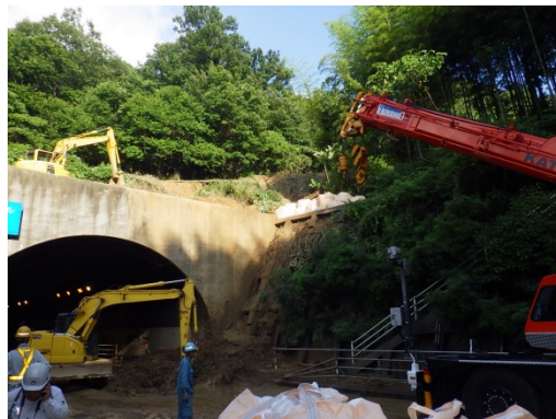
土砂流出復旧作業状況（福山市）
