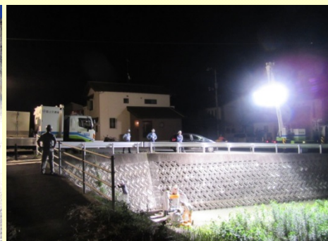
排水・照明作業状況（福山市）
