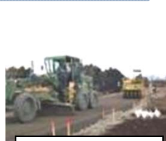
丁張りに合わせて施工
