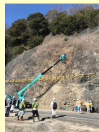
被災状況調査
