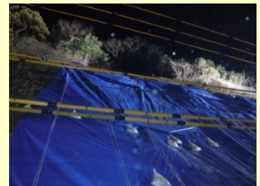
養生シート設置
