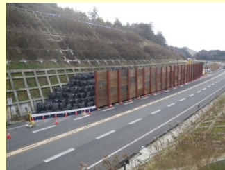
大型土嚢の設置
