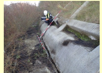
変状箇所の調査
