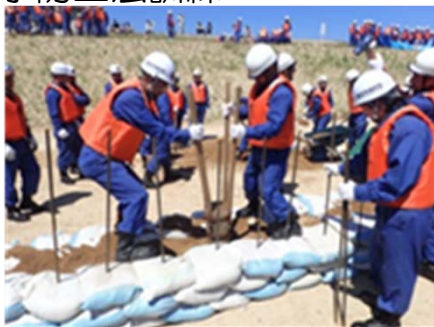
水防団による水防訓練 （積み土のう工）
