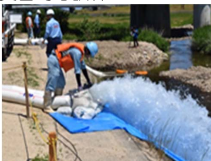
排水ポンプ車運転訓練（国交省）
