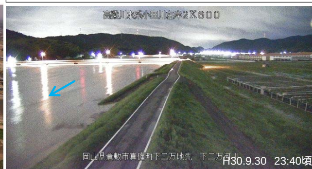
台風24号に伴う洪水の状況(小田川左岸2.6kから上流)
