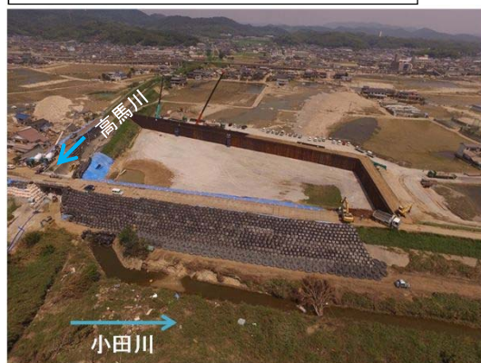
【H30.7豪雨】小田川左岸3.4k 堤防緊急対策実施状況
