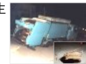
下水道の老朽化による道路陥没
