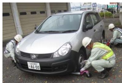
車両移動用機械設置
