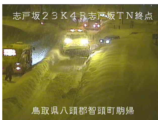
除雪作業状況
