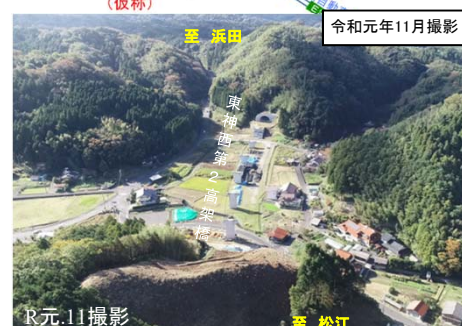
写真③出雲・湖陵道路 東神西第2高架橋付近の工事の様子
