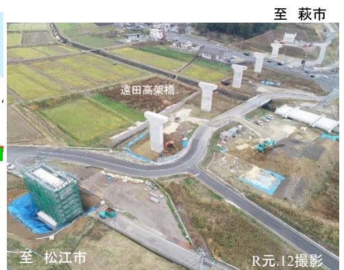
写真① 遠田高架橋の工事の様子
