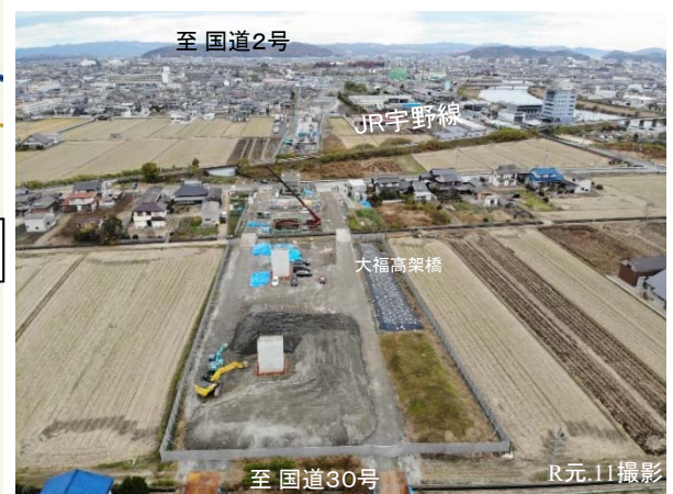
写真①大福高架橋 施工状況
