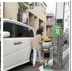
<歩行の支障となる電柱の事例>
