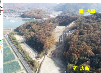
写真②カプト南町地区の工事状況
