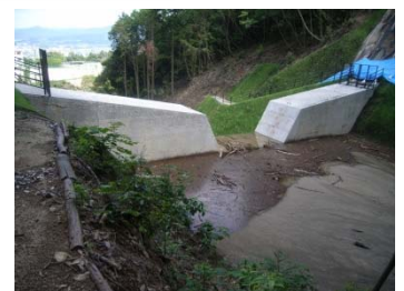
土石流の捕捉状況
