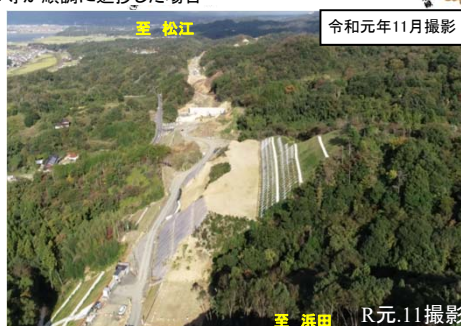
写真②湖陵・多伎道路 三部地区の工事の様子
