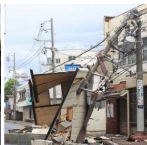
<飛来物による電柱倒壊の事例>
