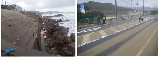
写真1 海岸浸食に伴う、転倒の恐れのある擁壁
