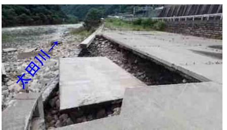
【護岸損傷】L=20m
