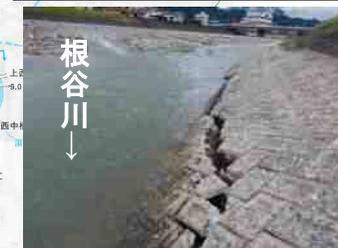
【護岸損傷】L=20m
