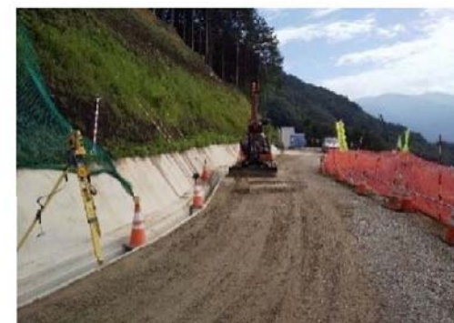
【ICT建機による路盤敷均し】
