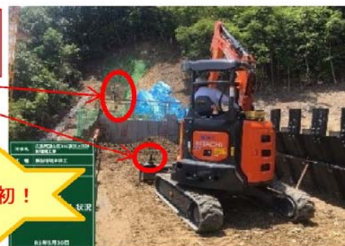
【ICT建機による本堤内部材敷均し】
