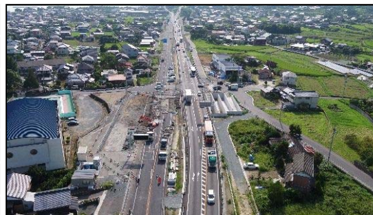
工事現場全景
