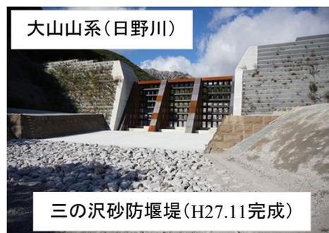
透過型砂防堰堤イメージ
