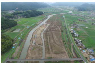
【樹木繁茂管理：初期状況】
