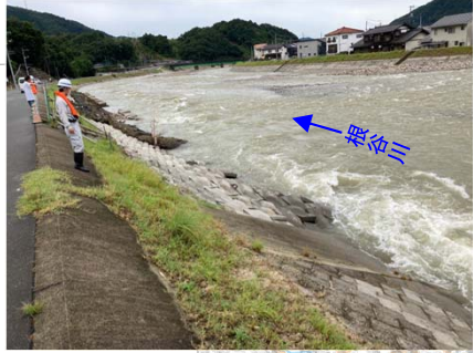
2021-08-15 08:17 根谷川 左岸4.0k 連節ブロック崩壊 L=100m
