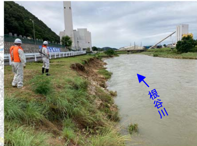
2021-08-15 08:42 根谷川 左岸1.2k土羽土流出 L=100m
