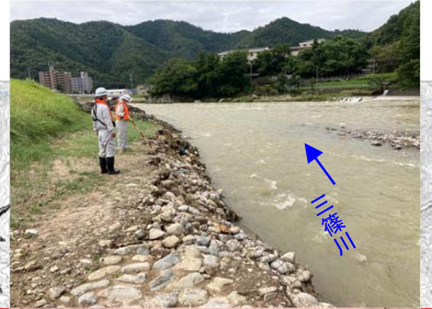
2021-08-15 10:59 三篠川 左岸6.2k 河岸浸食 L=100m
