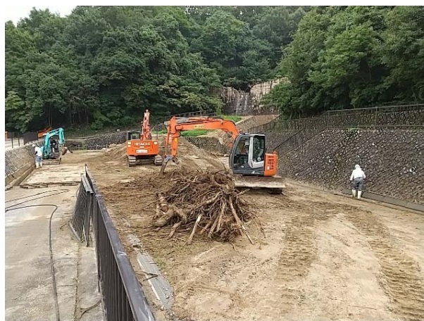
砂防堰堤下流の遊水池における土砂等撤去作業の状況 (R3. 8. 21撮影)
