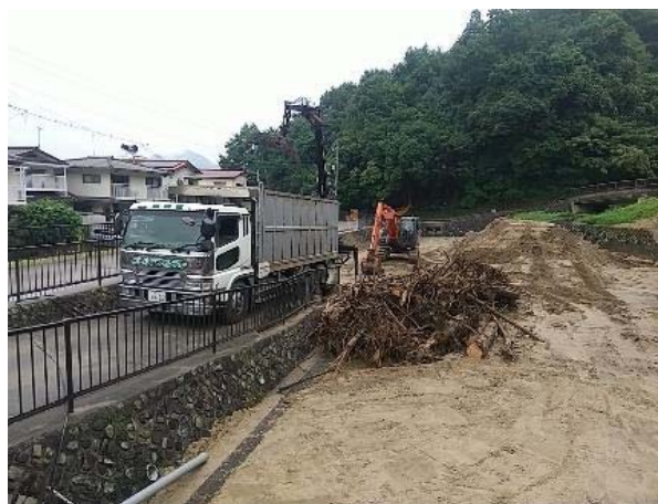
砂防堰堤下流の遊水池における土砂等撤去作業の状況 (R3. 8. 21撮影)
