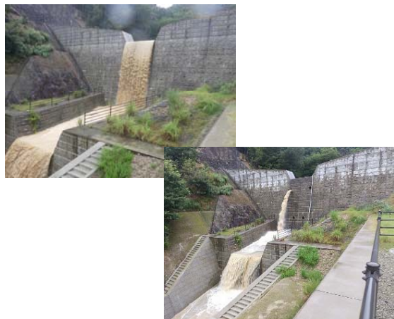
下流から見た砂防堰堤の状況
