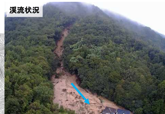
土石流氾濫・被害状況
