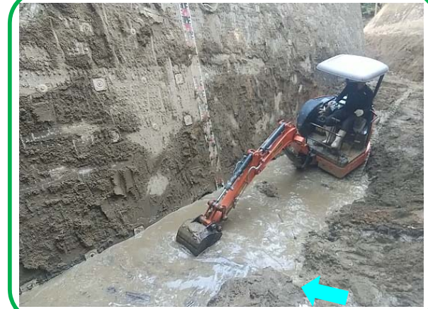
土砂等の撤去状況 (R3.9.25撮影)
