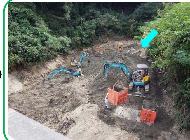
土砂等の撤去状況 (R3.9.24撮影)
