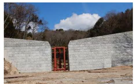
砂防堰堤の整備のイメージ
