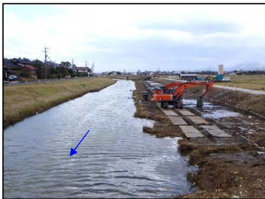
新内藤川河道掘削状況(暫定改修断面→本改修断面)
