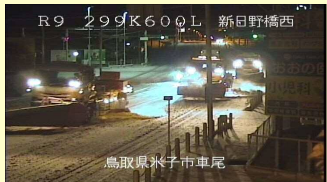
除雪作業（米子市車尾）
