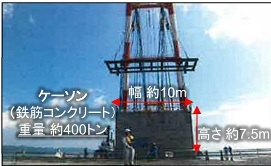
【ケーソン吊り出し】陸上で作られたケーソンをクレーン船で吊り上げて運搬します
