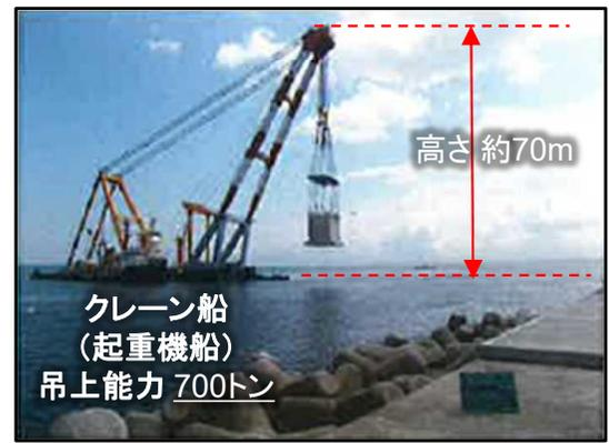
【ケーソン据付】運搬したケーソンをマウンドに据付けます
