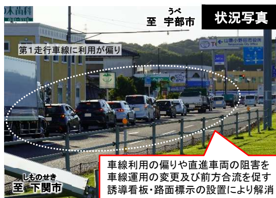
<<車線運用の変更、前方合流を促す誘導看板・路面標示の設置を予定>>
