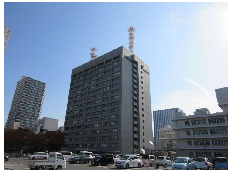
現況写真(外観)
