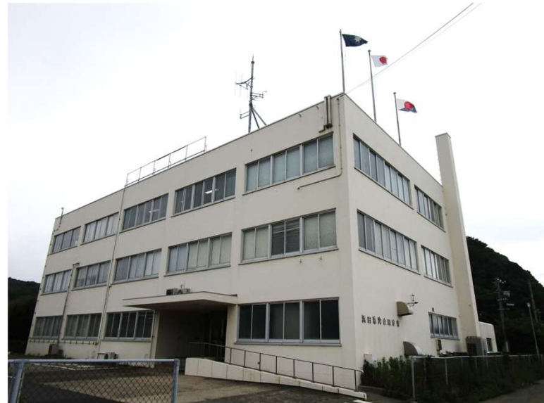
現況写真(外観)
