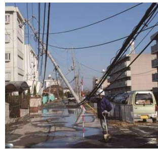
<飛来物による電柱倒壊の事例>
