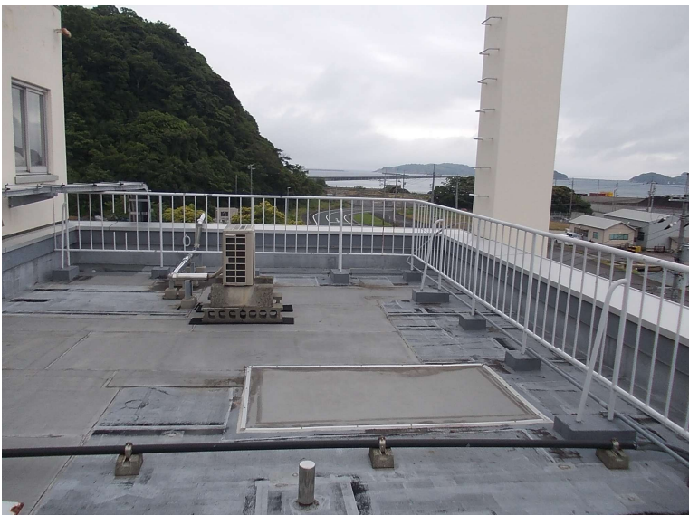
現況写真(屋上)
