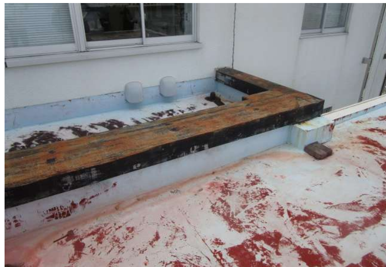
現況写真(屋上)
