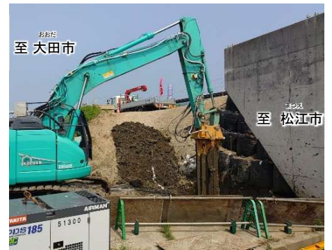
【写真①】からさで大橋付近の施工状況
