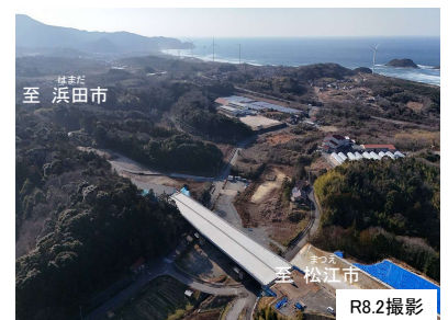
【写真②】本谷地区の施工状況
