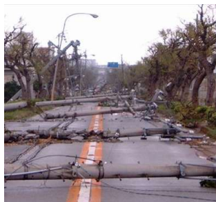
<電柱の倒壊による道路閉塞の事例>
