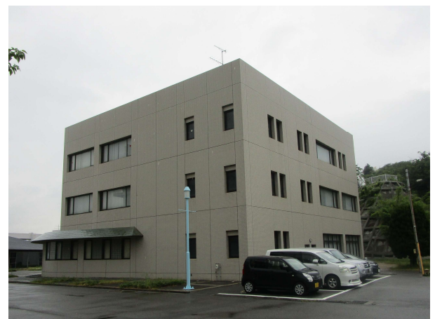
現況写真(外観)
