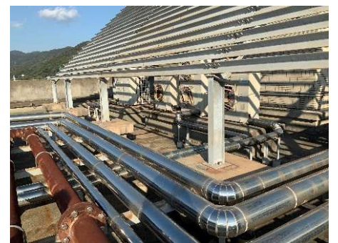
現況写真(屋上機械設備)
