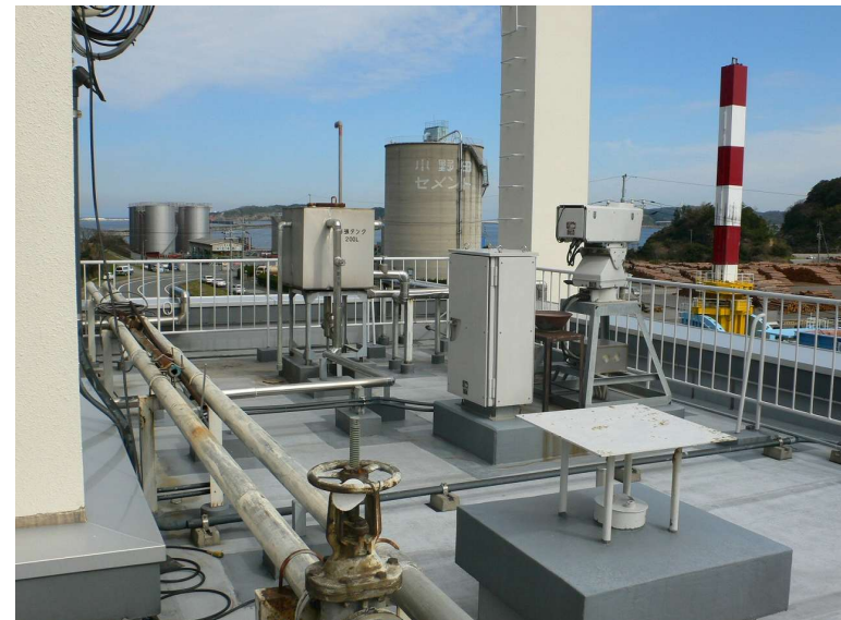
現況写真(屋上)
