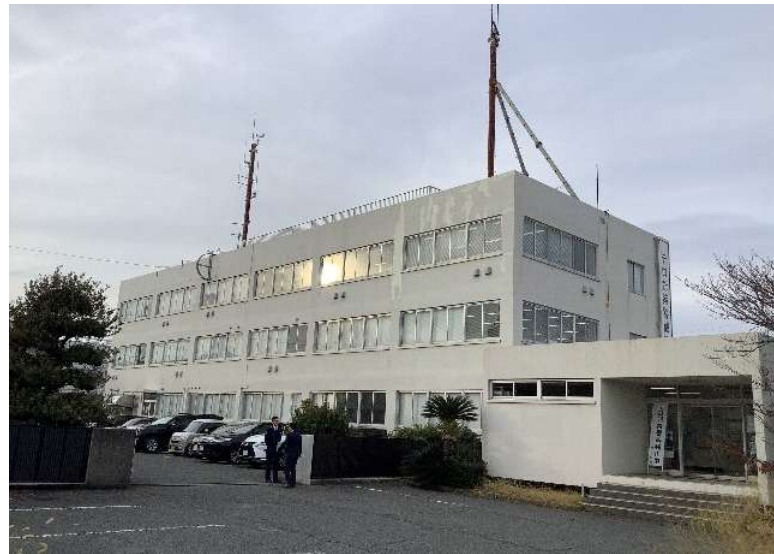
現況写真(外観)
