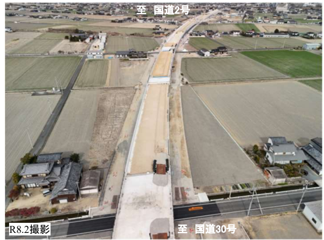
【写真①】 藤田地区 施工状況
