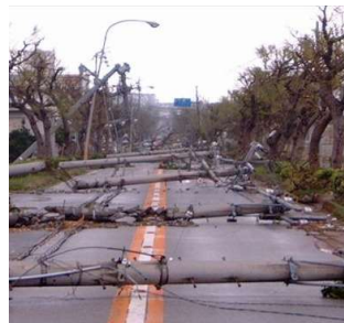
<電柱の倒壊による道路閉塞の事例>
