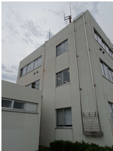
現況写真(外壁)
