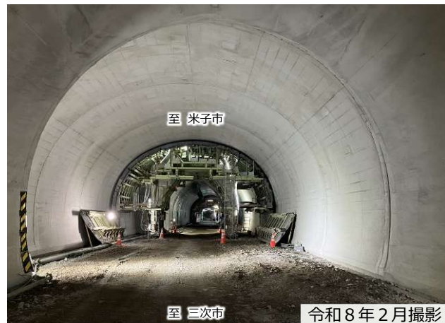
【写真①】 覆工コンクリートの施工状況
