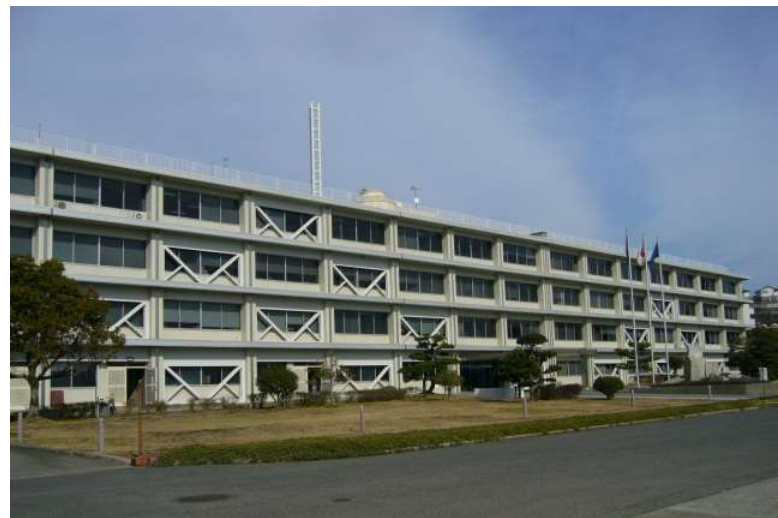
現況写真(外観)
