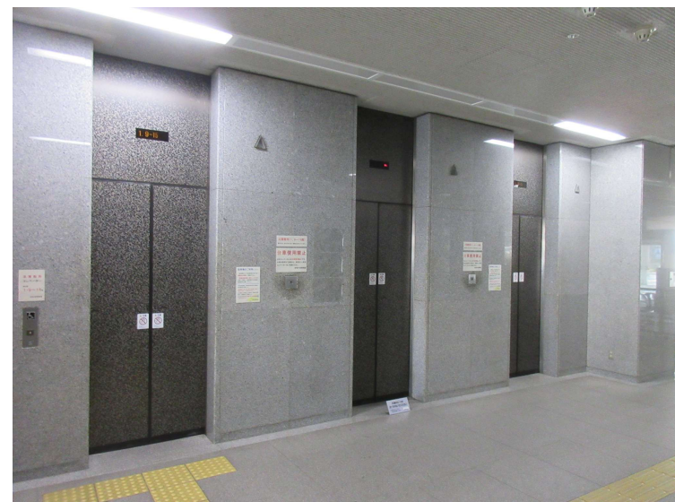
現況写真(エレベーター)
