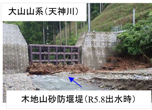
土砂・流木捕捉事例
