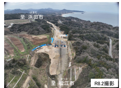
【写真①】福光地区の施工状況
