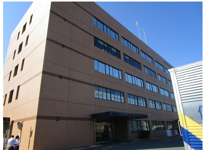
現況写真(外観)
