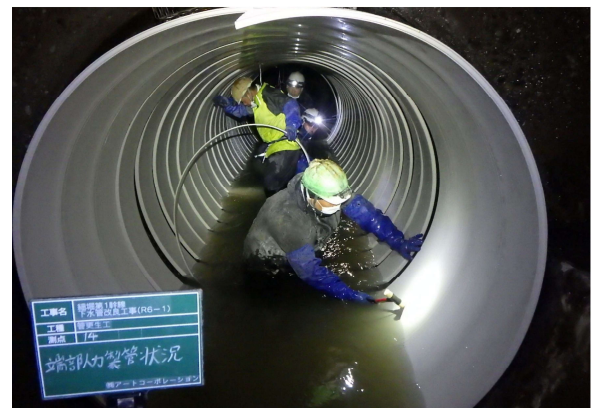
再生工法による改築イメージ
