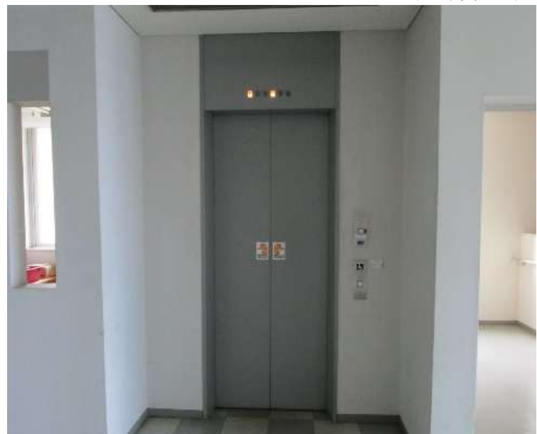
現況写真(エレベーター)
