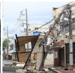
<飛来物による電柱倒壊の事例>
