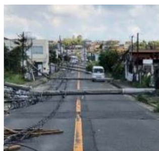
<電柱の倒壊による道路閉塞の事例>
