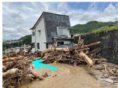
土石流による被災状況 (令和3年8月 安佐南区山本)
