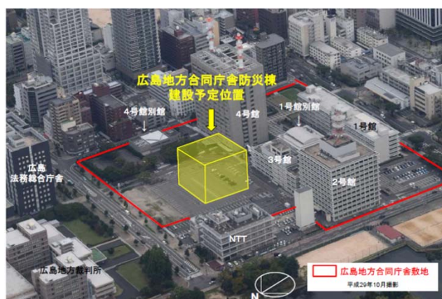
広島地方合同庁舎防災棟 建設予定位置
