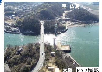
【写真②】神島地区の施工状況
