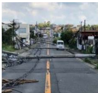
<電柱の倒壊による道路閉塞の事例>
