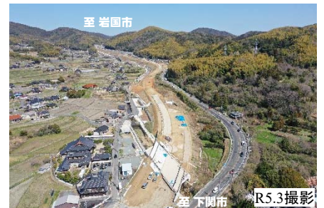
【写真②】石原地区の施工状況
