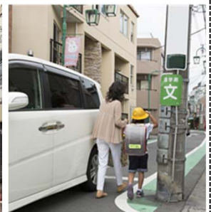
<歩行の支障となる電柱の事例>
