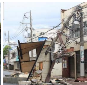
<飛来物による電柱倒壊の事例>
