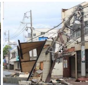
<飛来物による電柱倒壊の事例>
