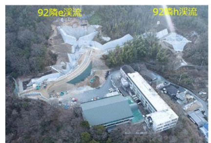
砂防堰堤の整備状況
