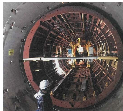
写真②施工状況(二次覆工打設)
