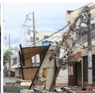
<飛来物による電柱倒壊の事例>
