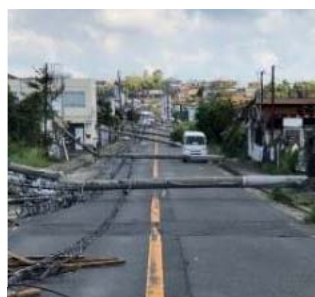
<電柱の倒壊による道路閉塞の事例>
