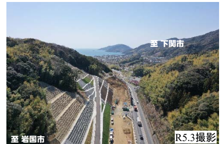
【写真①】椿峠地区の施工状況
