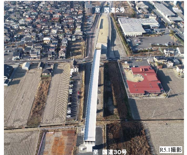
【写真①】大福地区の施工状況
