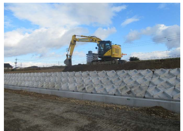
堤防整備の状況
