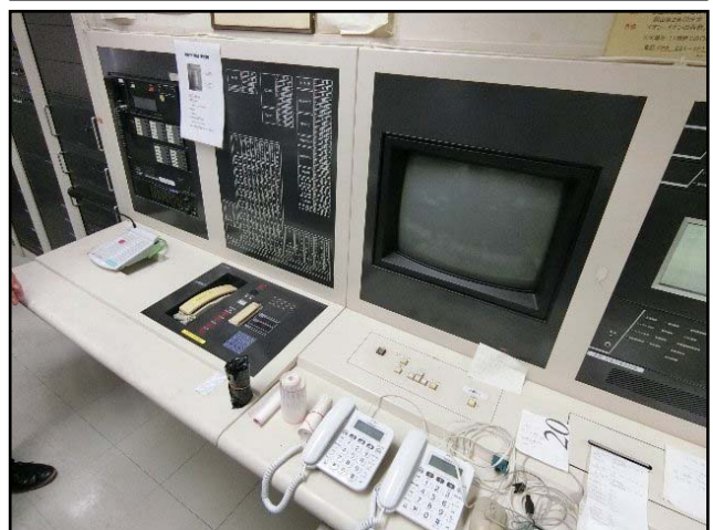
岡山第2地方合同庁舎(現況)
