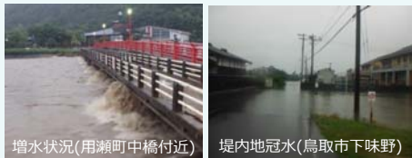
平成30年7月豪雨での被害状況
