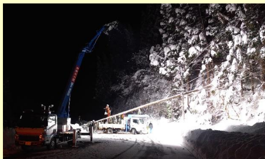
道路啓開作業の夜間照明支援（鳥取県八頭郡智頭町）
