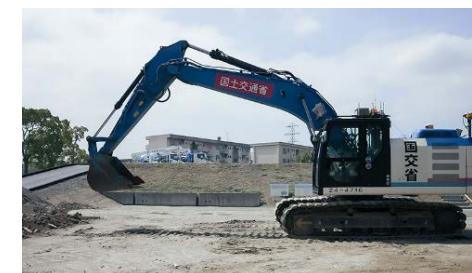
③遠隔操縦(無人化)施工
