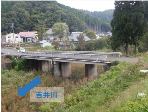
被災前の状況
