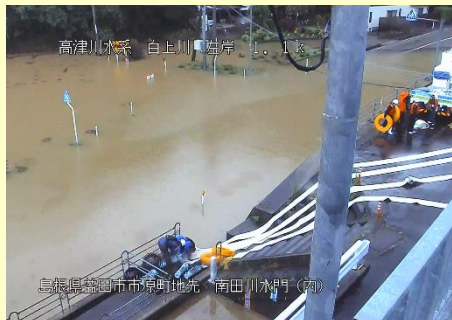
排水ポンプ車による排水作業状況 島根県益田市（白上川）
