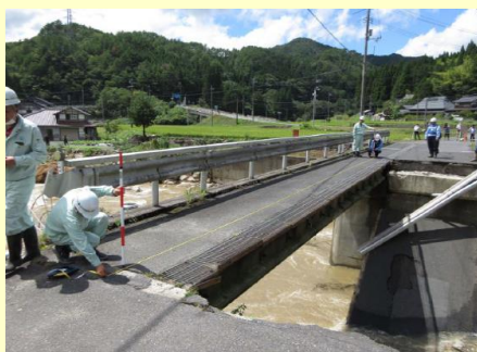
落橋復旧に係る調査作業 岡山県苫田郡鏡野町（町道大木山線）
