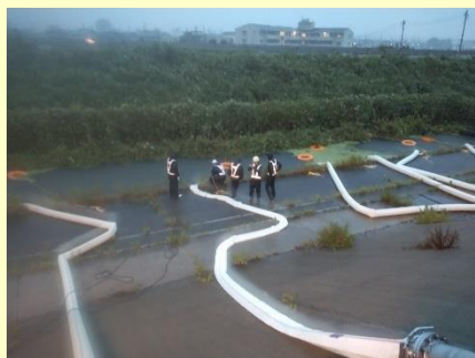
排水ポンプ車による排水作業 鳥取県倉吉市（国府川）
