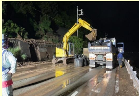
法面崩落復旧作業状況 山口県下関市（国道191号）
