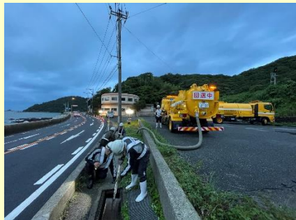
水管渠内の堆積土砂排除作業状況 山口県下関市（国道191号）
