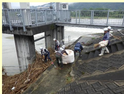
樋門に堆積した流木撤去作業 鳥取県鳥取市（千代川）
