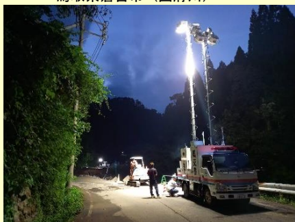
照明車による夜間照明作業 鳥取県鳥取市（佐治川）
