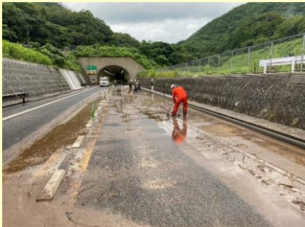
道路冠水箇所の路面清掃作業状況 鳥取県岩美郡岩美町（馳馳山バイパス）
