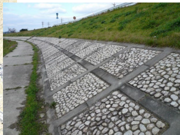
高水護岸工の施工例
