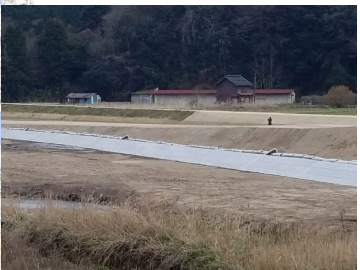
低水護岸工の施工例
