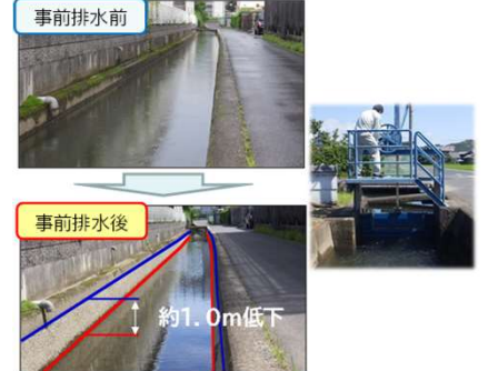
取水の中止・樋門の開放による水位調整状況
