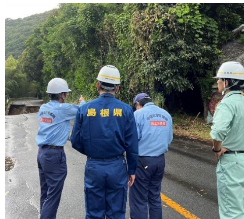
被災状況調査
