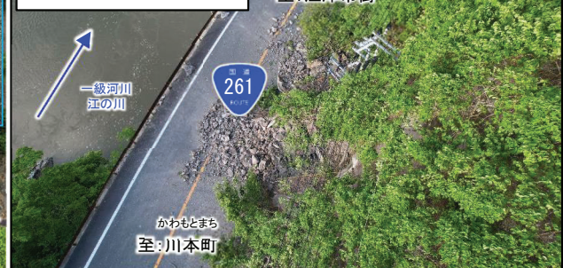
写真②(被災状況)
