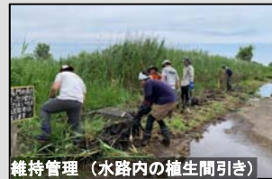
維持管理 (水路内の植生間引き)
