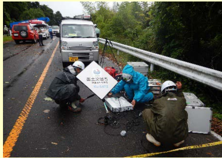
簡易監視カメラ設置 (鳥根県出雲市：県道大社日御碕線)
