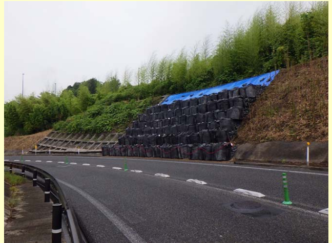
大型土のう設置 (広島県三次市：尾道自動車道)
