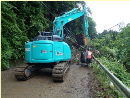
大型土のう設置 (鳥取県智頭町：鳥取自動車道)
