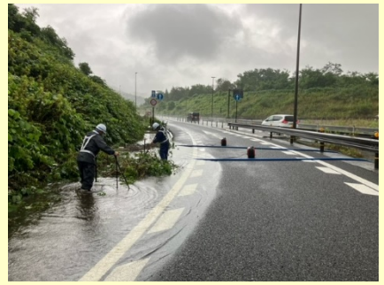
道路冠水の排水作業 (広島県東広島市：東広島呉道路)
