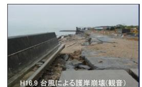
H16.9 台風による護岸崩壊(観音)
