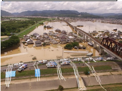
【平成30年7月豪雨】（岡山県倉敷市）
