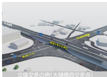
立体交差の例(大樋橋西交差点)
