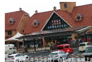
道の駅「キララ多伎」自動車駐車場上屋
