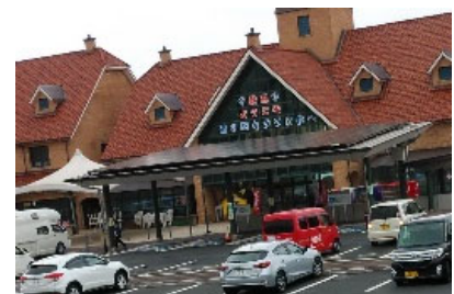
道の駅「キララ多伎」自動車駐車場上屋
