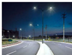
LED照明 (消費電力約56%削減)
