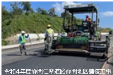
令和4年度静岡仁摩道路静岡地区舗装工事
